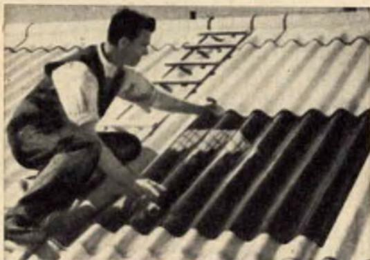
Fig. 10 - Per migliorare l'illuminazione interna di edifici già da tempo costruiti, senza dover apportare alcuna modifica alle strutture portanti, sarà possibile procedere alla sostituzione di settori di copertura non trasparenti con lastre di laminato plastico.
