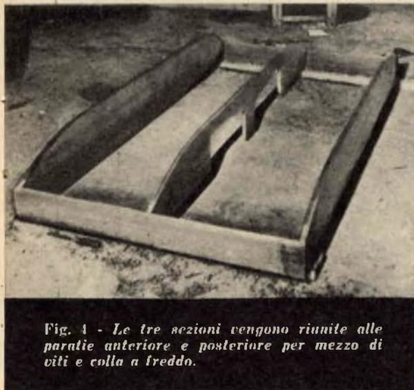
Fig. 4 - Le tre sezioni vengono riunite alle paratie anteriore e posteriore per mezzo di viti e colla a freddo.
