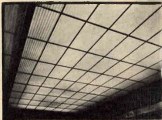
*Fig. 8 - Esempio di utilizzazione di lastre di laminato plastico ondolato traslucido nella costruzione di una grande e luminosa tettoia piana.*
