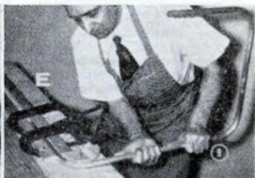
Il primo passo nella costruzione del sedile è l'esecuzione della curvatura «C», da fare con l'aiuto della forma come in fig. 7. Il morsetto serra il tubo tra i due correntini e gli impedisce di uscir fuori. La seconda operazione (fig. 8) consiste nell'esecuzione della
