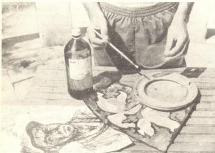
La foto mostra tutti gli elementi necessari per l'inizio della operazione di plastificazione: si notino la bottiglia di cloroformio, il pennello a setole morbide ed il coperchio di una scatola di medicinali.
