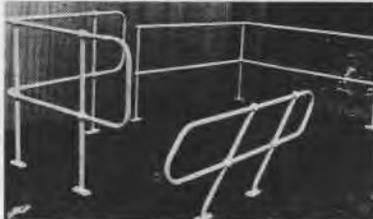
Un nuovo giunto brevettato per tubi è anche stato recentemente sviluppato da tale Compagnia. Il giunto consente di collegare dei tratti di corrimento tubolare con una giunzione che si nota appena. I tubi sono congiunti insieme da un collare centrale girevole, che contiene un meccanismo a bullone e dado che, una volta serrato a fondo, rende il giunto perfettamente liscio.
