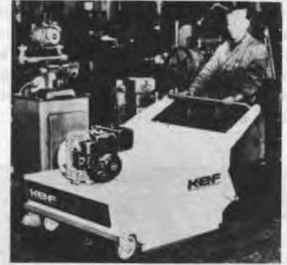
La macchina, che è completamente automatica, può marciare all'indietro, oltre che in avanti. La scopa principale è larga 90 cm, e vi è una scopa laterale a comando indipendente, che in totale assicura una larghezza di spazzamento di 110 cm. Si può montare una modificazione antifiama ed un sedile per l'operatore. Gli altri due modelli di cui sono stati ridotti i prezzi (il modello 526 e quello 526E, con comando elettrico) sono fondamentalmente simili al 536 ma hanno dimensioni minori.
