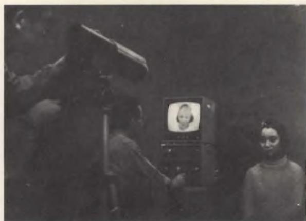
Fig. 3 - Il nuovo tubo IC per telecamera è in grado di riprodurre un'immagine anche in condizioni di oscurità prossime al nero.
