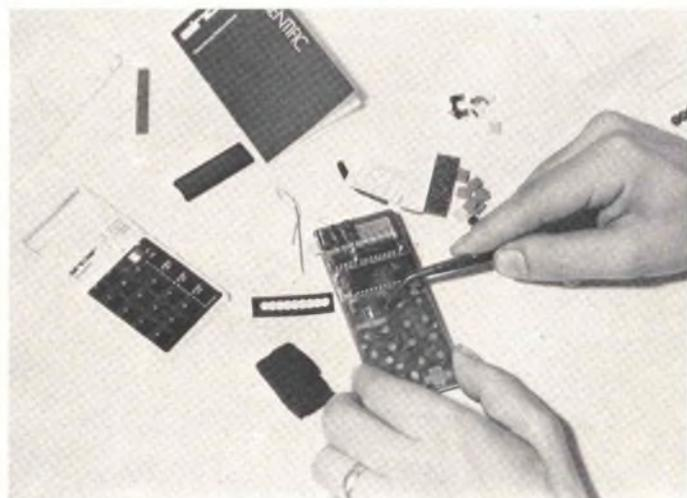
Fig. 9-C - Questa foto illustra i tre condensatori elettrolitici installati nelle rispettive posizioni, e chiarisce anche come deve risultare dopo il montaggio, l'unità di indicazione numerica UR. La foto chiarisce anche la posizione dei tre circuiti integrati.
