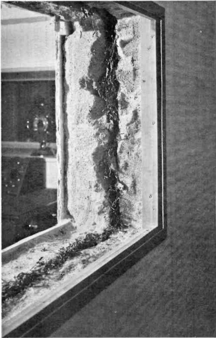
EEL GRASS FOR SOUND-INSULATION SANDWICHED IN WALLS OF PUMICE
