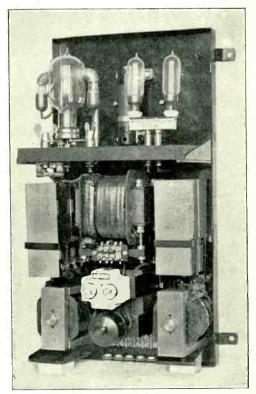
By courtesy, Gesellschaft für drahtlose Telegraphie. Fig. 15. Interior of apparatus for use with A.C. mains.
